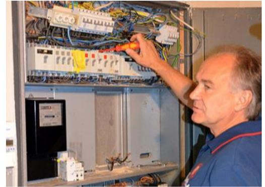
Für den neuen Orgel-Motor musste die Starkstromleitung den geänderten Normen entsprechend erneuert werden. Ing. Walter Wagner führte die **Elektroinstallationen** sowie die Aktualisierung mit neuen Sicherungsautomaten durch.
