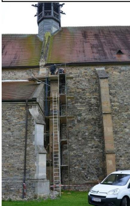
Im Rahmen der bischöflichen Visitation 2016 wurden bereits die ersten **Renovierungsarbeiten an der Kirche** durchgeführt. Am Mauerwerk mussten zwei herauswachsende Bäumchen entfernt werden. Die verschobene Deckplatte eines Strebepfeilers wurde vom Restaurator Mag. Wedenig abgebaut, der Untergrund gereinigt und diese kraftschlüssig wieder versetzt und verfugt. Weiters wurden am Sakristeidach die gebrochenen Ziegel ausgetauscht.
