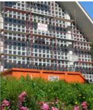
Die Sanierungsarbeiten der Pfarrkirche gehen weiter. Bis Ende August wird die neue Glasfront an der Ostseite errichtet sowie der Vollwärmeschutz angebracht. Bitte um Spenden für die Kirchensanierung – die Kontonummer finden Sie im Impressum des Pfarrblattes und Erlagscheine liegen in der Pfarrkirche auf.
