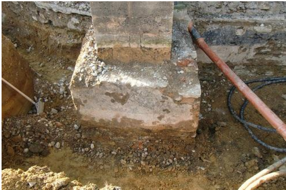
Wuchtiges Pfeilerfundament
