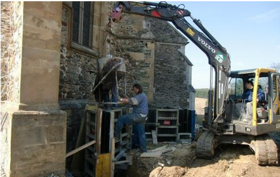
Unterfangen der Kirchenmauer
